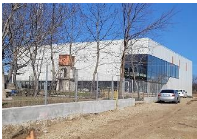
Sala sport (constructie noua) - Tamboesti – imagine 2022
