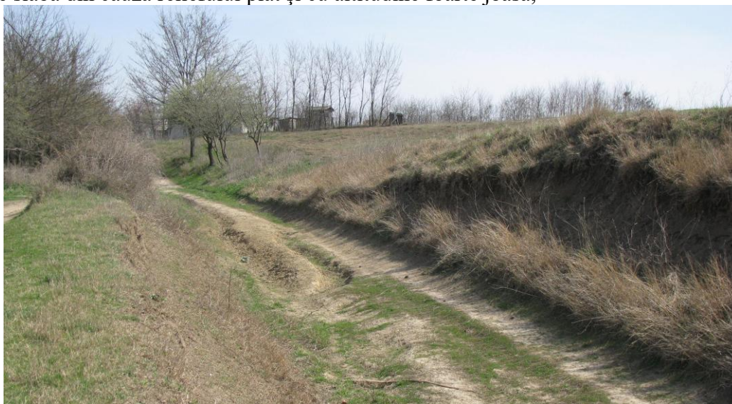
EROZIUNE IN ROCI FRIABILE
